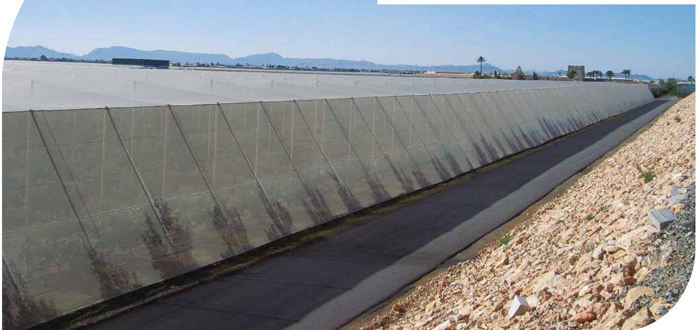
**Reti tessute in polietilene per la protezione delle colture in serra da mosche, afidi e tripidi. La particolare sezione del filo determina una tessitura molto fitta e ravvicinata che impedisce il passaggio degli insetti ma non il passaggio dell'aria tra esterno ed interno serra. Per il loro peso le reti sono installate su strutture fisse.**
